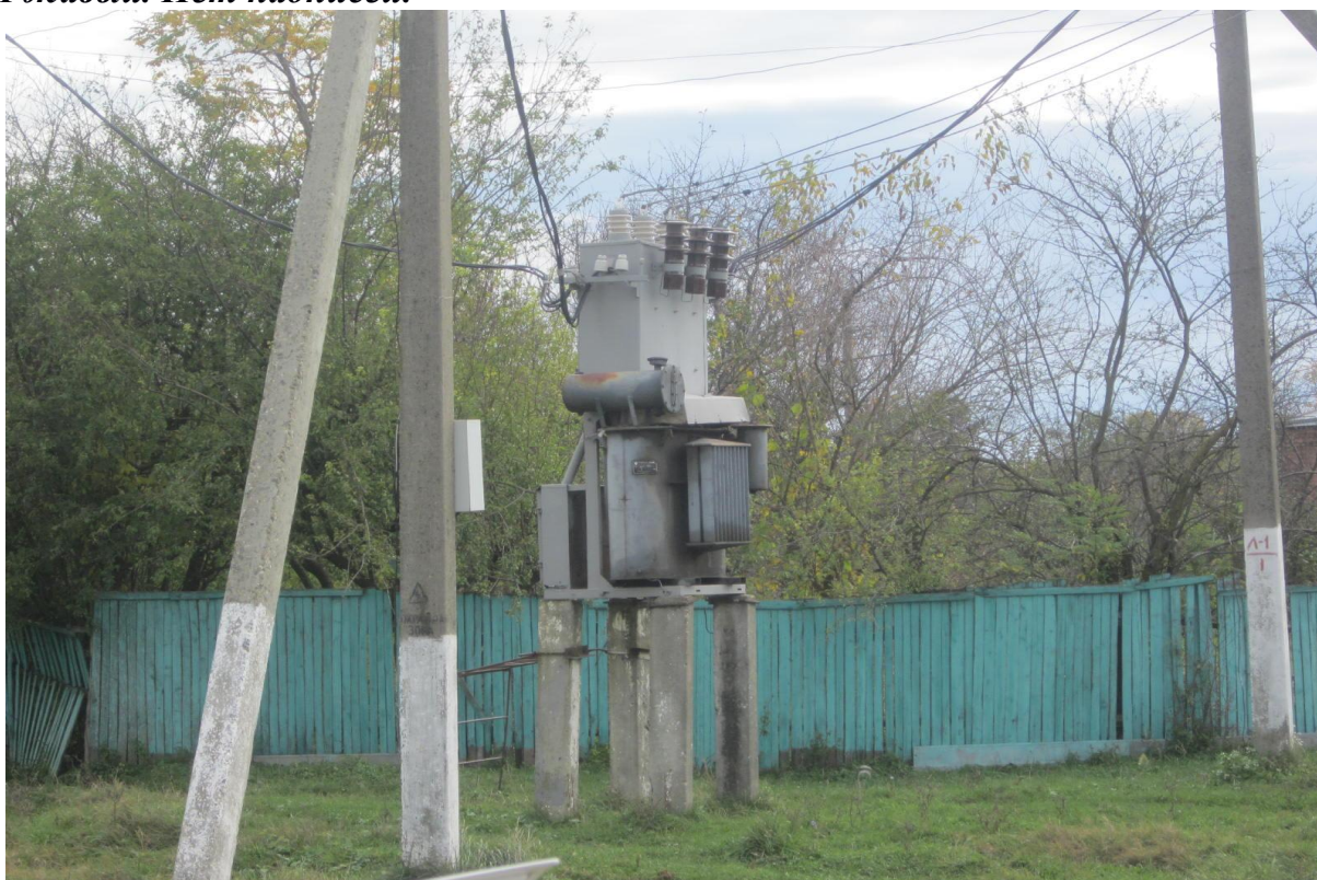
Трансформаторная подстанция-100 кВт. а.Кабехабль. ул.Ленина. ТП замаслен. Ржавый. Нет надписей.
