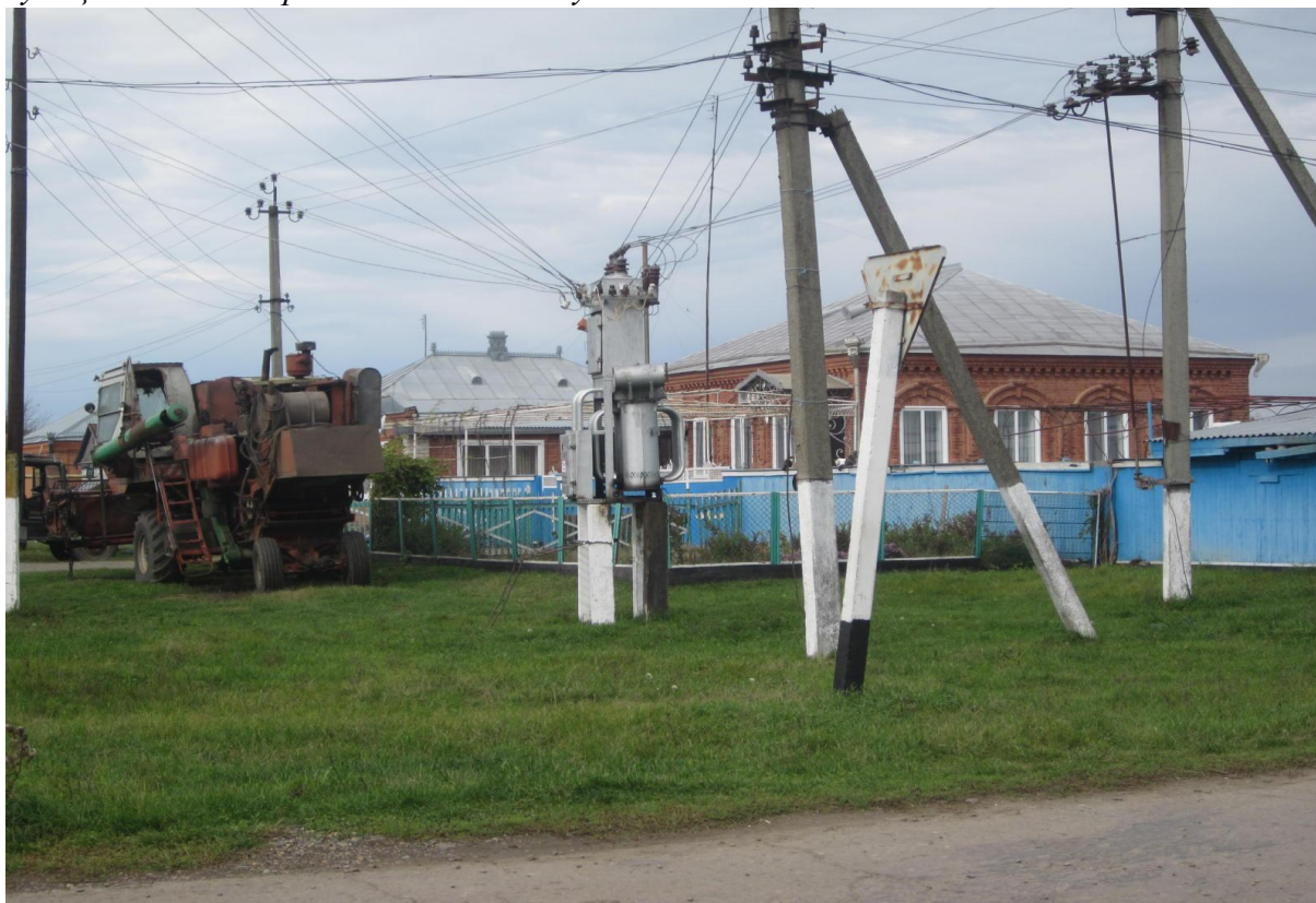
Трансформаторная подстанция-100 кВт. ул.Шовгенова и Кузнечная. Надписей нет. Изолятор висит.
