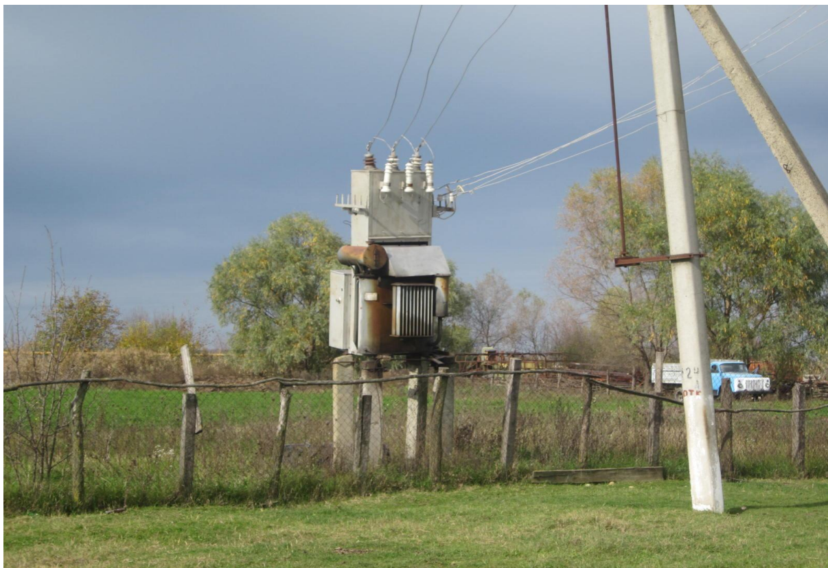
Трансформаторная подстанция-100 кВт. а.Пиичо. ул.Новоселов. ТП замаслен. Стоит по углом 4°. Ржавый. Надписей нет.
