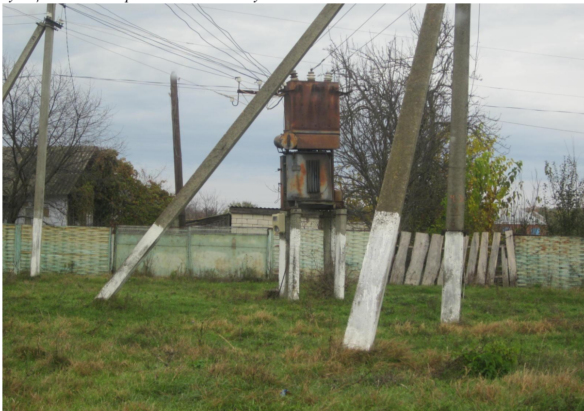
а.Пиизов. Трансформаторная подстанция-100 кВт.ул.Пиизов. ТП ржавый. Нет надписей. Стоит под углом 3°.
