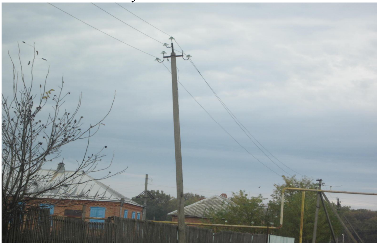
ЛЭП-10 кВт. Столб стоит с наклоном 6°.
