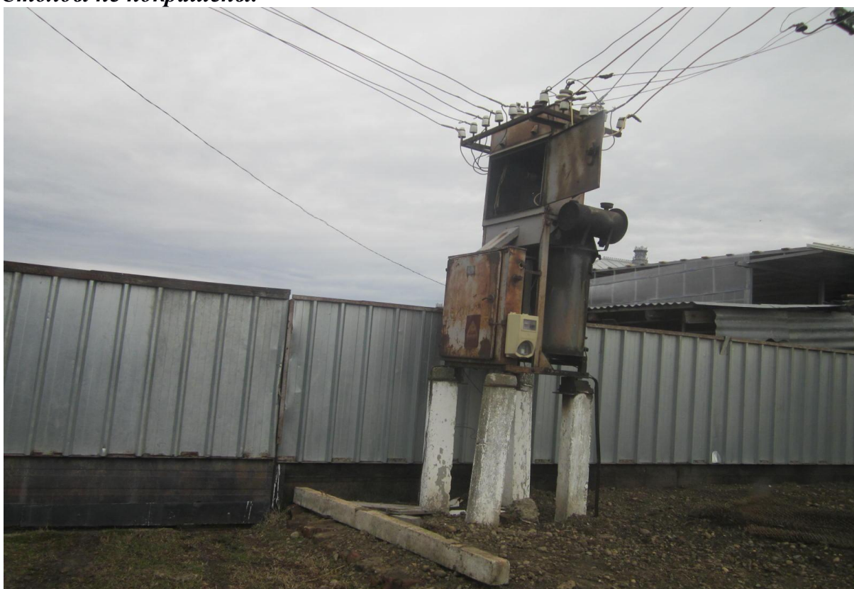
Трансформаторная подстанция-100кВт. ул.Пишкова. ТП замаслен. Ржавый. Надписей нет.
