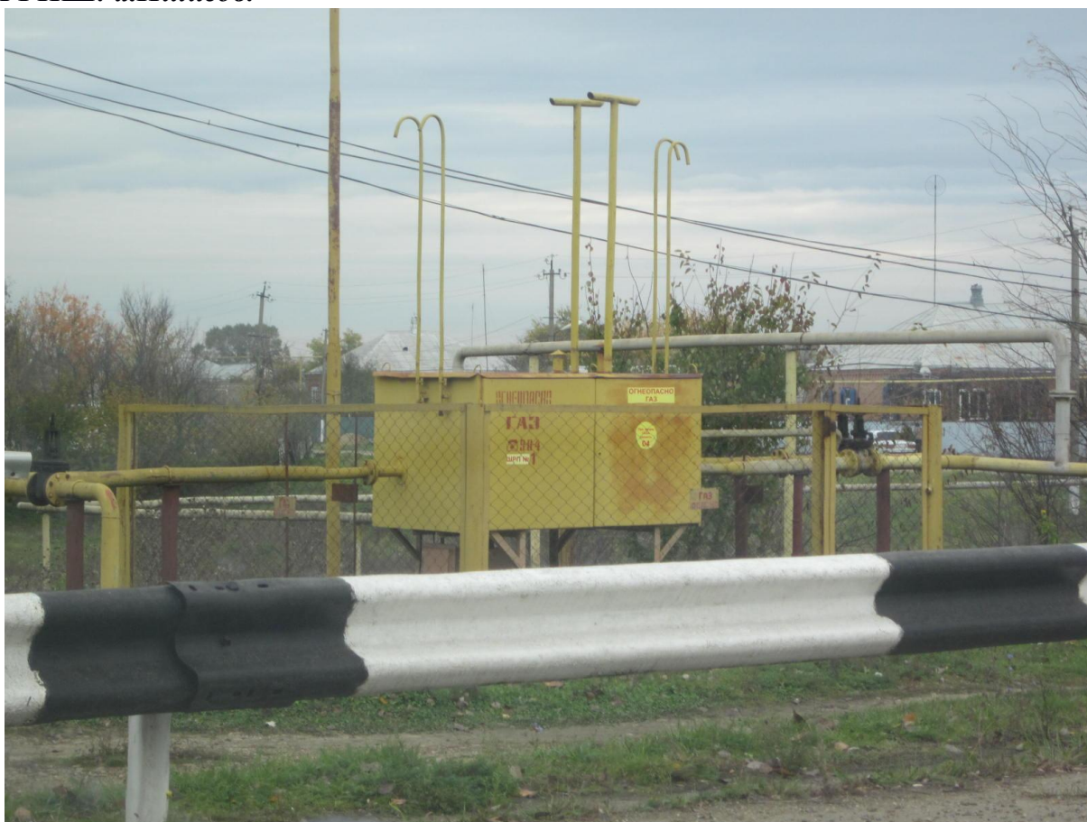
ГРПШ. а.Кабехабль. ул.Ленина. Задвижка ржавая.
