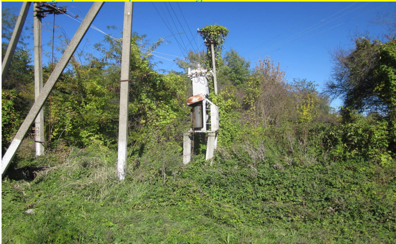
Трансформаторная подстанция-100 кВт. Заросла травой, стоит с наклоном под углом 5°. Замаслен. Скрутки.
