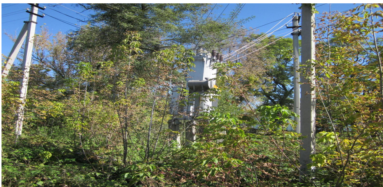
Трансформаторная подстанция-100 кВт. Стоит с наклоном под углом 3°. Разъединитель ржавый. Надписи отсутствуют. Расположен в зарослях деревьев и травы..
