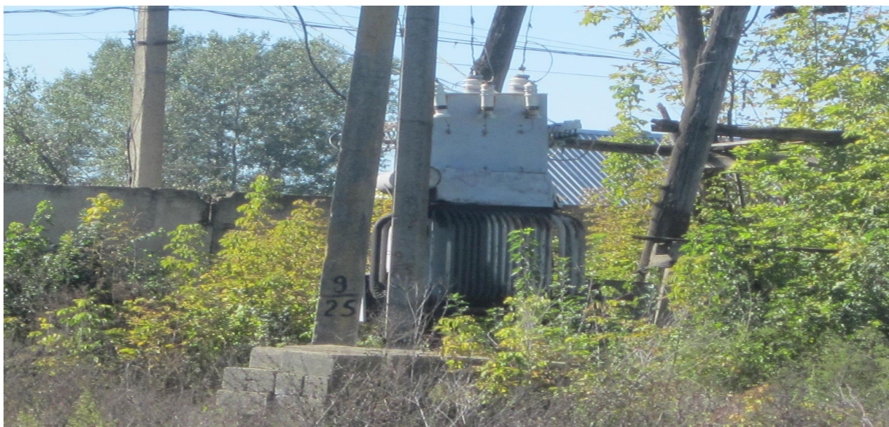
Трансформаторная подстанция-100 кВт. ул.Краснооктябрьская. Стоит в зарослях, отсутствуют надписи. Разъединитель ржавый. Нет прохода.
