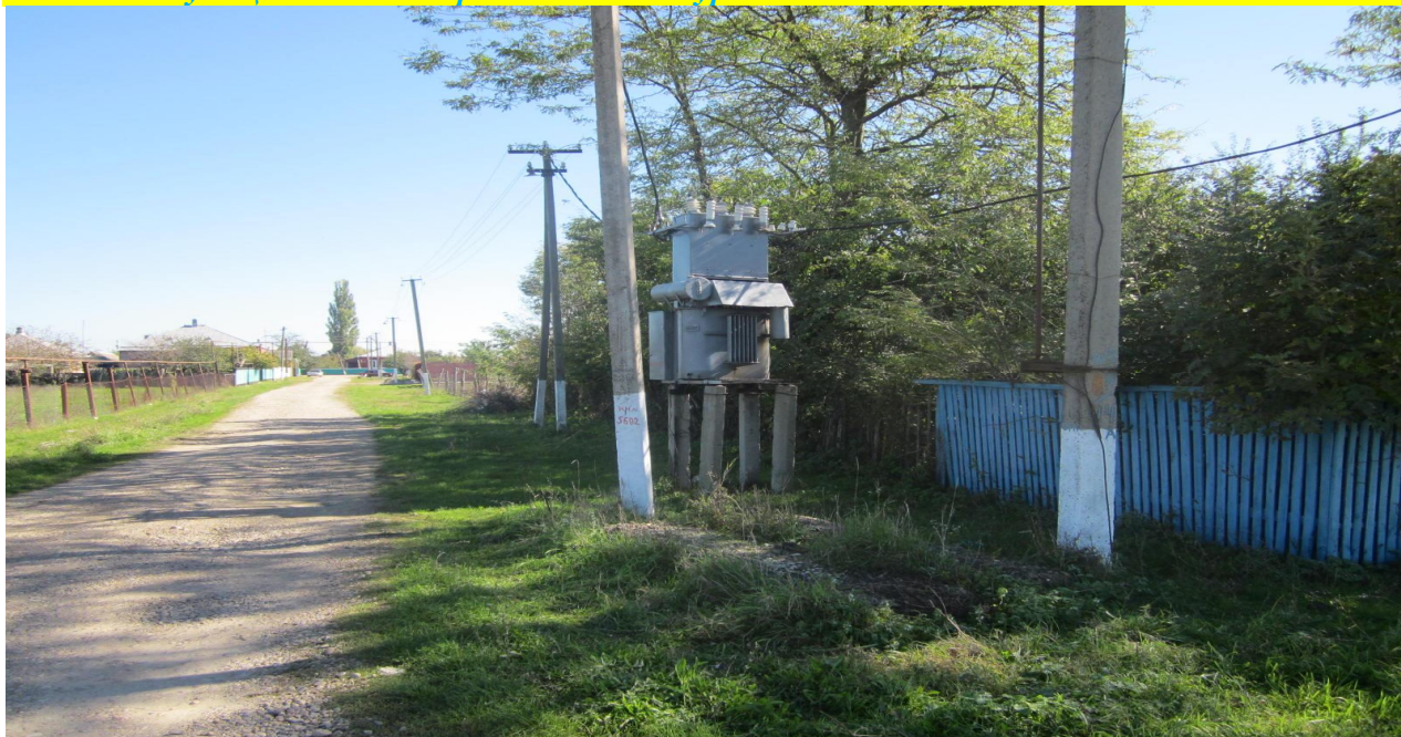
Трансформаторная подстанция-160 кВт. ул.Андрухаева. Отсутствуют надписи. Разъединитель ржавый. Столбы не стоят под различными углами. На опорах отсутствуют надписи об охранных зонах..
