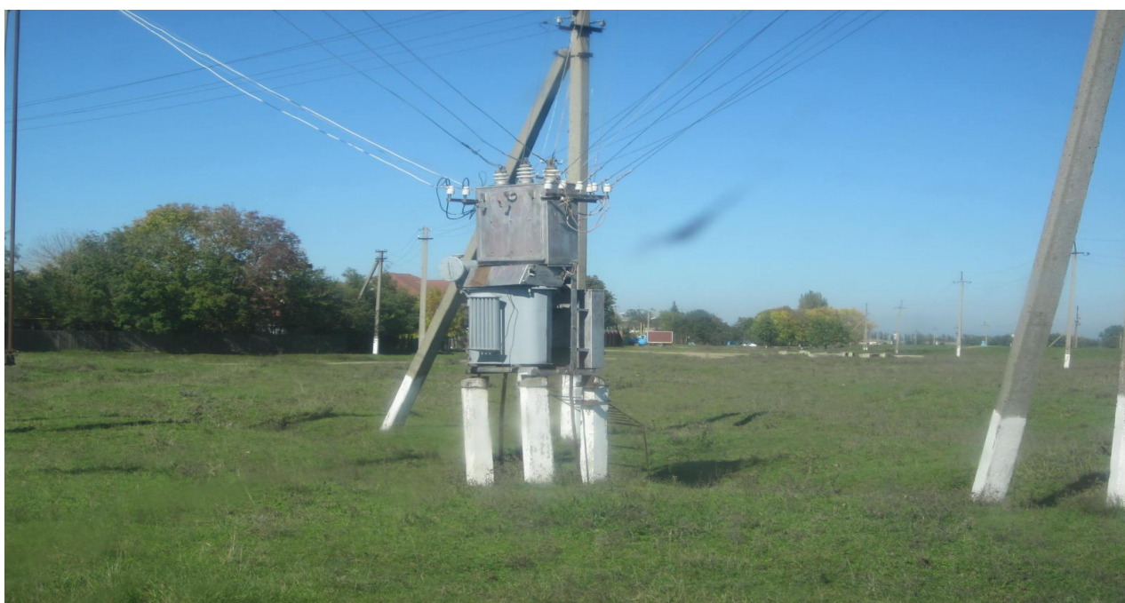
Трансформаторная тподстанция-100 кВт. ул.Краснооктябрьская. Отсутствуют надписи. Разъединитель ржавый.
