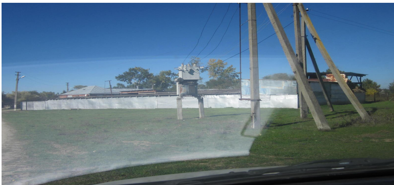
Трансформаторная подстанция-100 кВт. ул.Речная. Отсутствуют надписи, Разъединитель ржавый, Замаслен.
