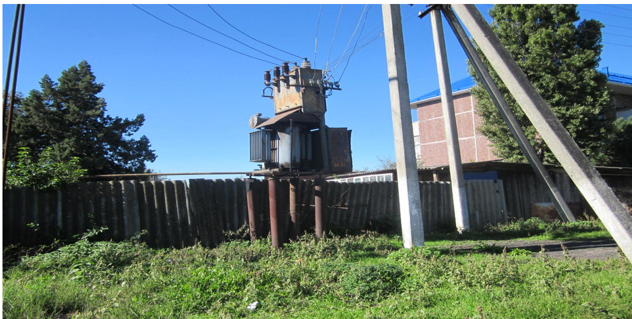
Трансформаторная подстанция-100 кВт. ул.Шовгенова. Стоит под углом 6°. Нет надписей. Разъединитель ржавый.
