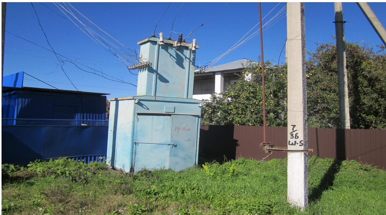
Трансформаторная подстанция- 160кВт. ул.Тургенева. Отсутствуют надписи, разъединитель ржавый, скрутки.
