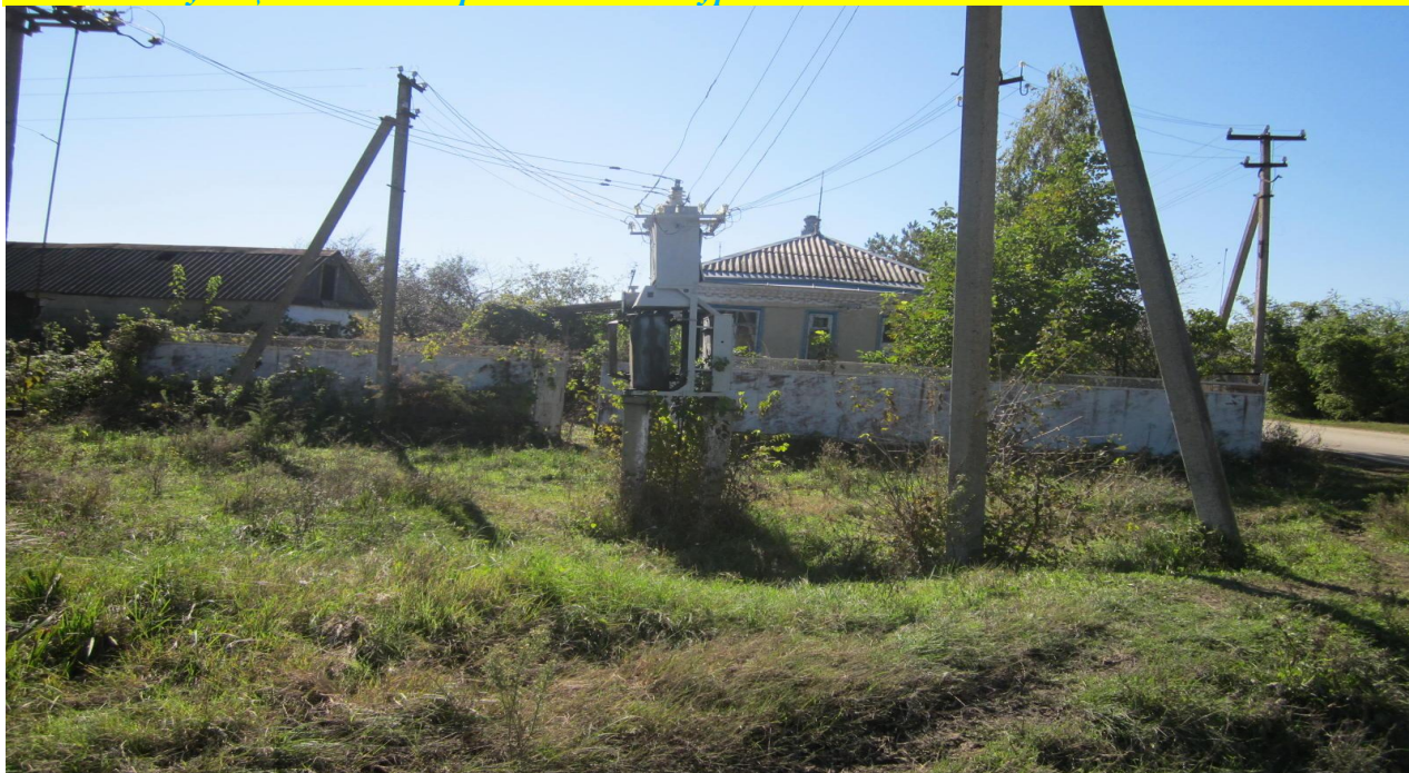
Трансформаторная подстанция-100 кВт. Нет ограждения. Замаслен. Скрутки. Надписей нет.
