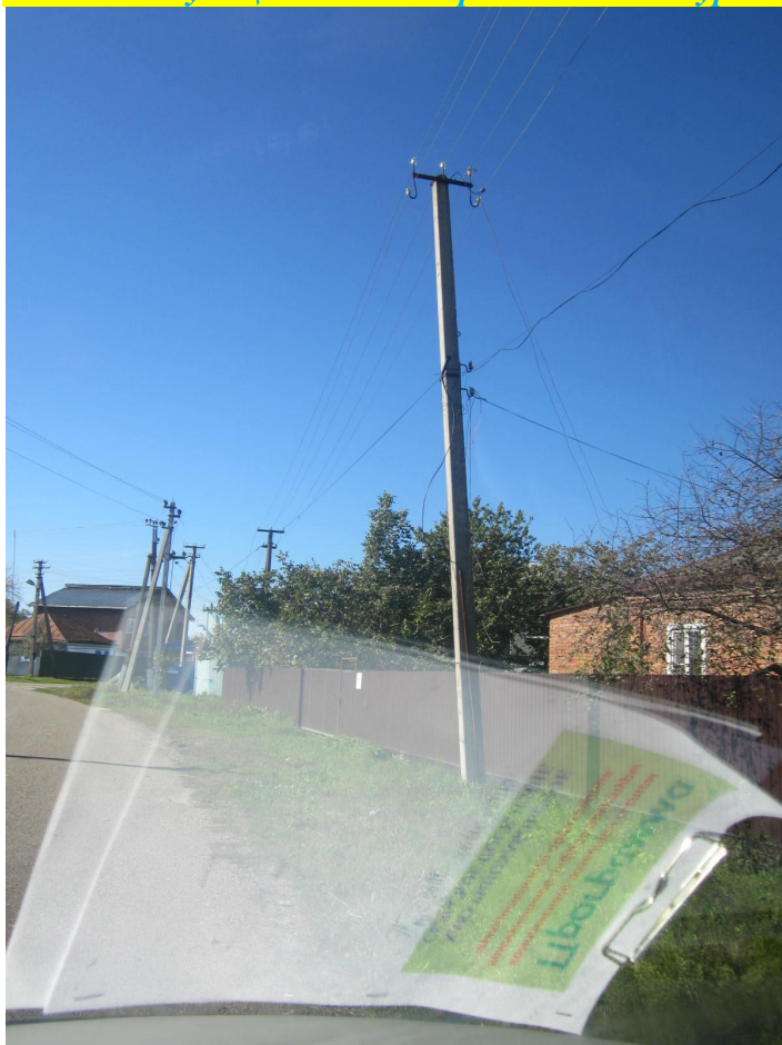
Аул Хакуринохабль. ул.Тургенева. Опора линий электропередач. Столб под углом 3°
