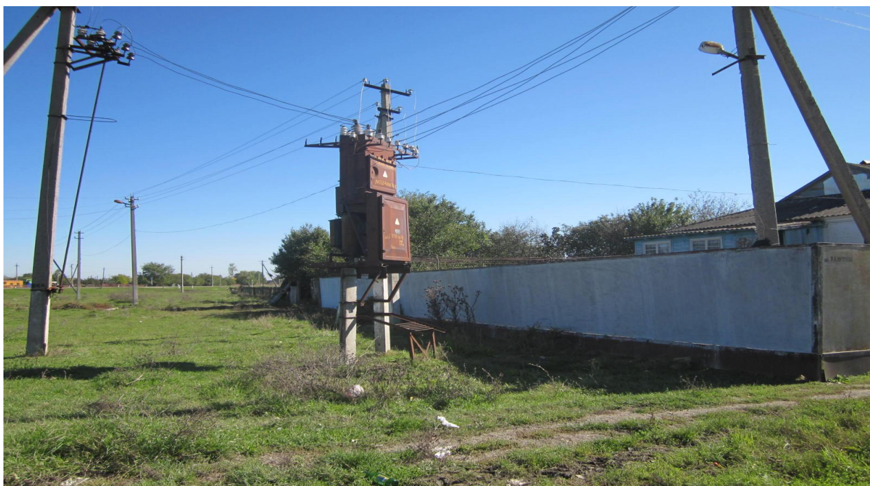
Трансформаторная подстанция-100 кВт. Отсутствуют надписи. Разъединитель
