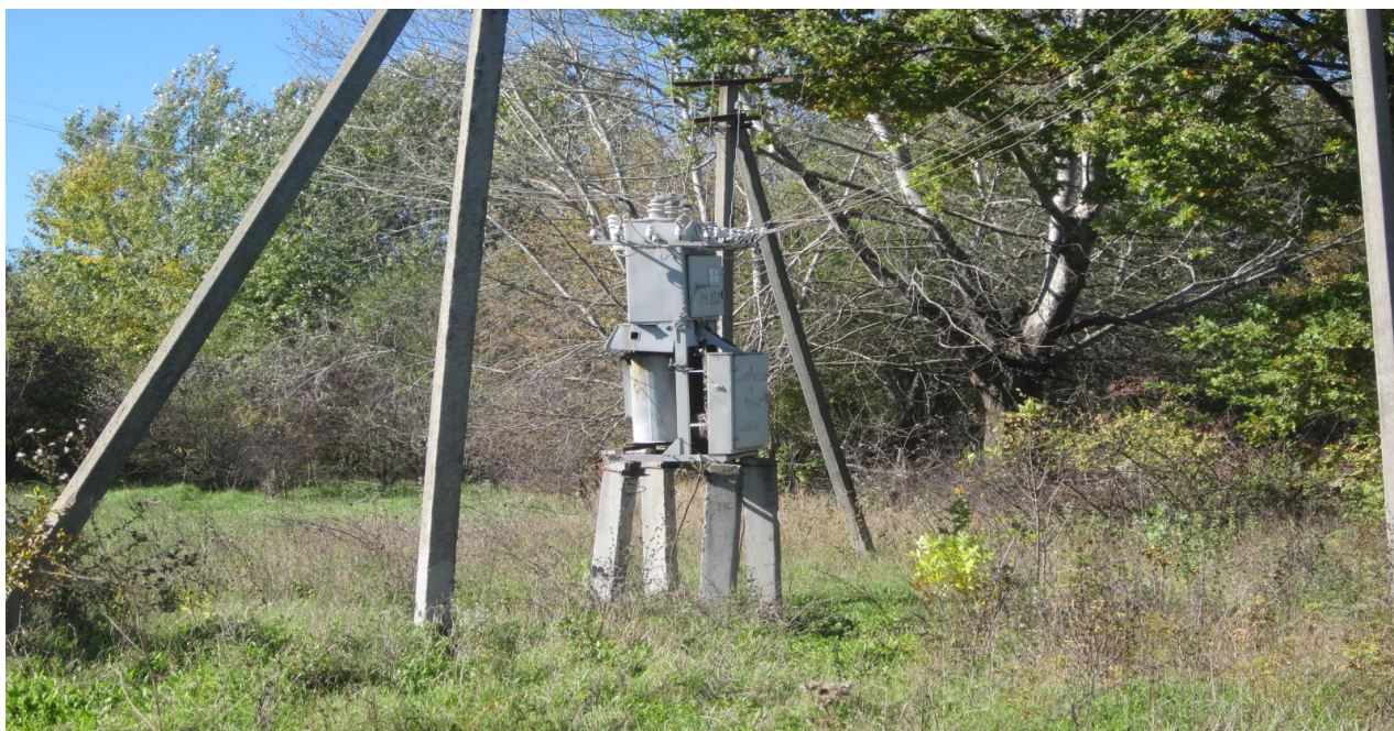
Трансформаторная подстанция-100 кВт. к.Дауров. Отсутствуют надписи, разъединитель ржавый, столбы не покрашены.
