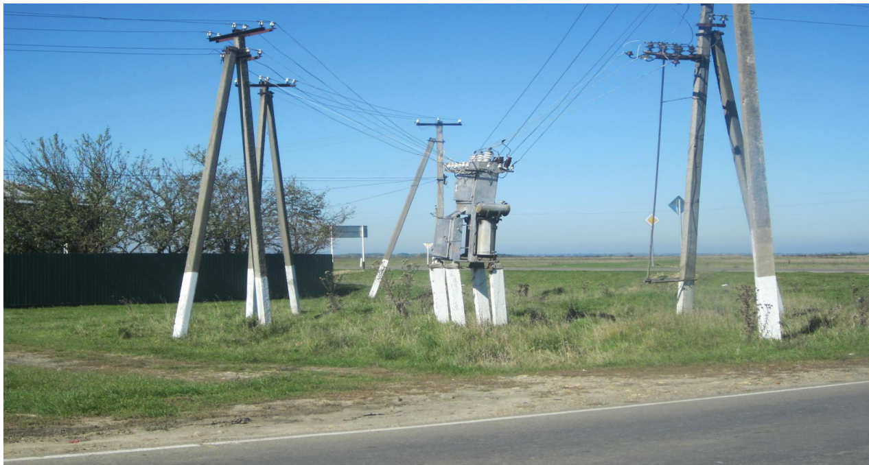
Трансформаторная подстанция-100 кВт. ул.Шовгенова. Стоит под углом 6°. Нет надписей. Разъединитель ржавый.
