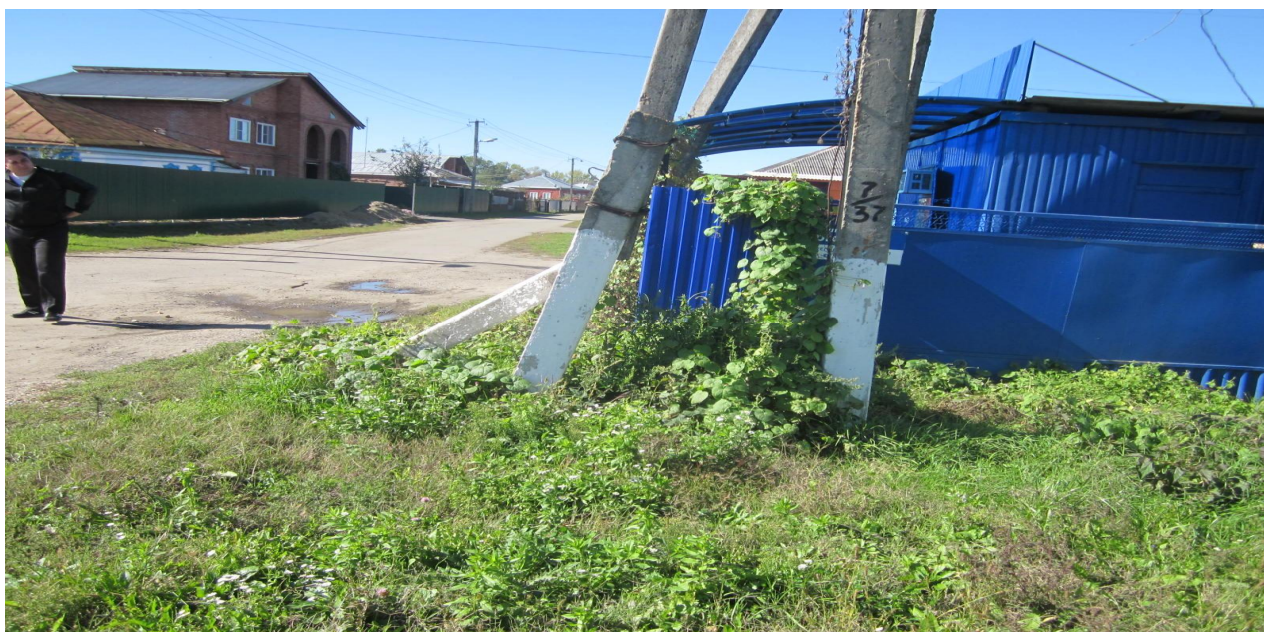
Опора линий электропередач. Нет ограждения от наезда транспорта.
